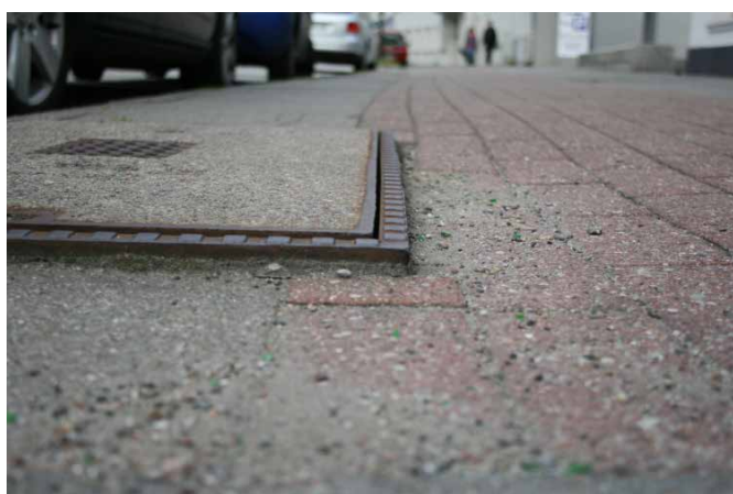
73.attēls - Lūka, kas ir vismaz 2,5 cm virs ceļa seguma līmeņa Hamburgā (Vācija) Avots: Rudolph (2011)
